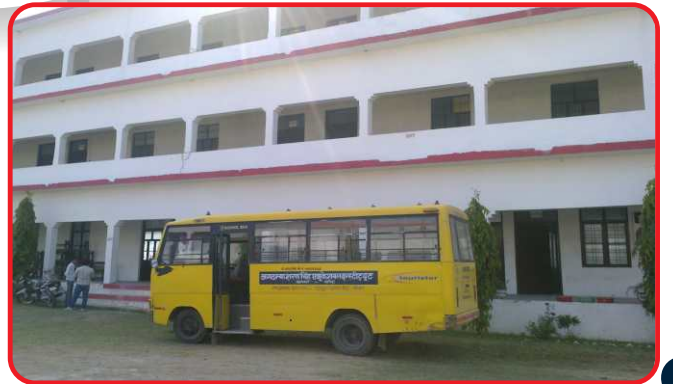
जगदम्बा शरण सिंह एजुकेशनल इंस्टीट्यूट, बेलसर-गोण्डा
